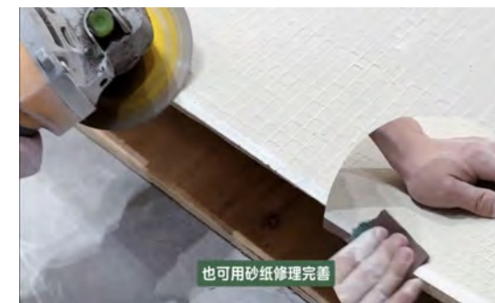
7. サンドペーパーで研磨して修復・仕上げも可能
