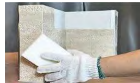
⑧乾いたスポンジで表面を清掃し、完成。
