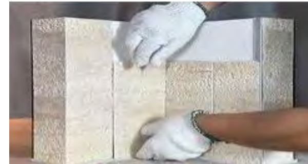
①陰角部分の製品を左重ねまたは右重ねで貼り付ける。
