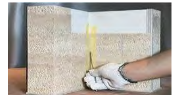
④目地棒で深く凹んだ、饱满な縫いを引く。
