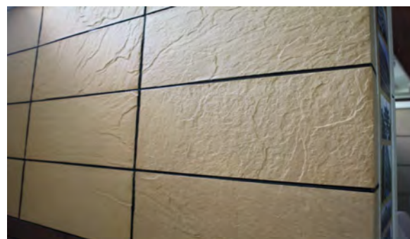
5.シリコンジェルで仕上げた縫い目、密閉性が良く、より洗練された雰囲気
