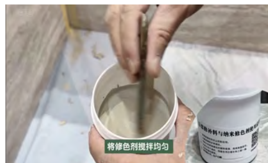
20.修色剤を均一に搅拌する
