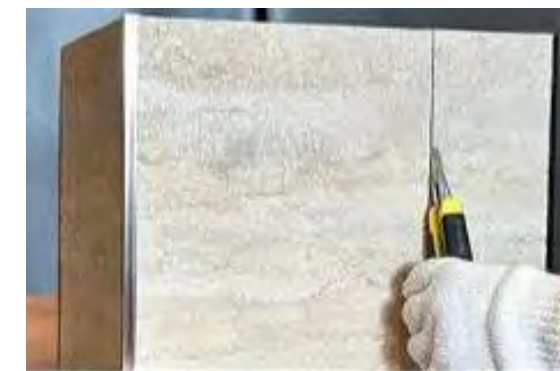
⑤縫いの幅を固定した後、小さな刃物で刃物縫い（自然縫い）を引く。
