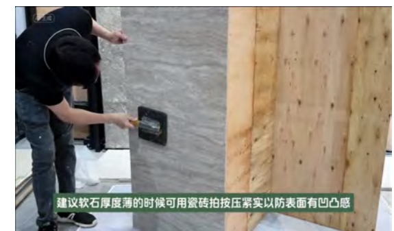
14. 壁に貼った後、タイル用のパットで押し て圧着し、表面の凹凸を防ぐ
