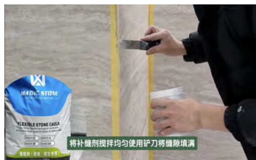
19.補縫剤を均一に搅拌し、ヘラを使って縫い目を完全に埋める
