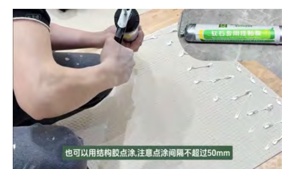
12. 構造用接着剤を点塗りする方法も可
