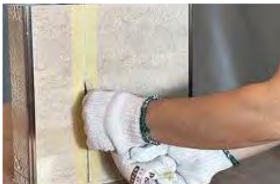
③同色のシーリング剤を均一に充填する。
