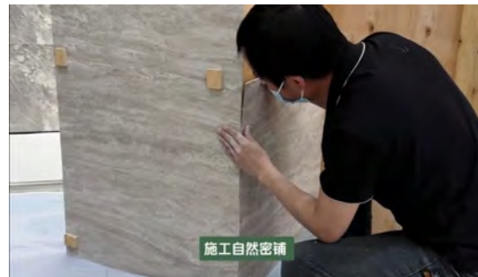
16.自然に密に敷き詰める施工
