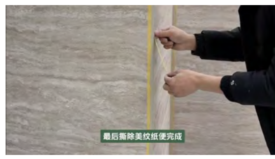
22.最後にマスキングテープを剥がして完成
