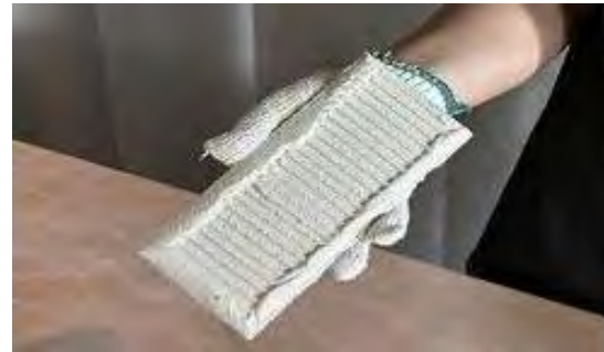
②製品の裏側の縁にスラリーを45° の角度で塗り、スラリーの高さを平面より約3mm高くする。
