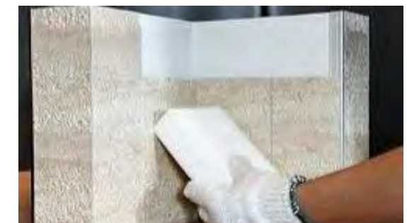
⑥乾いたスポンジで表面を清掃し、完成。
