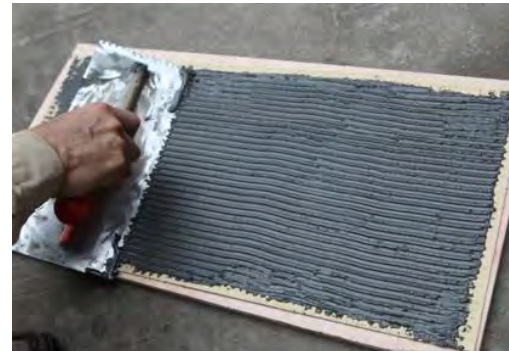
特柔生態石材などの大規格製品のスラリー塗布要求
