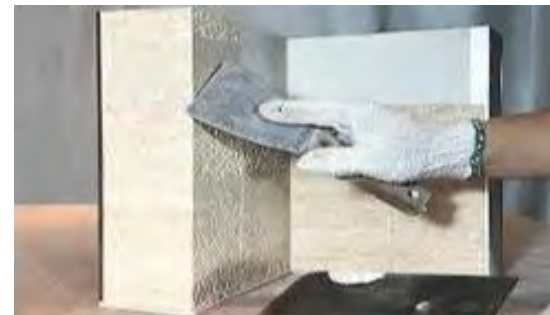
⑤スラリーが隙間を完全に埋めていない場合、同色シーリング剤で隙間を埋める。
