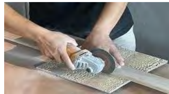
⑤測定したサイズに合わせて製品を切断する。
