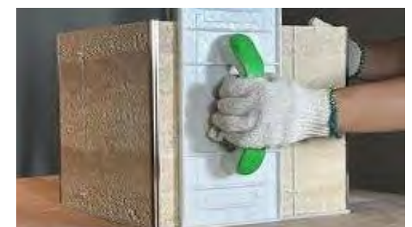
⑧打ち板で製品をしっかりと押さえつける、手で押すのは厳禁。
