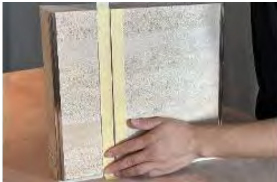
①製品に縫い目を残して貼り付けた後、製品の両側に美紋紙を貼る（凹凸のある製品は保護に注意）。
