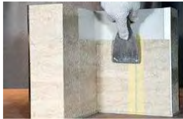
③小さなヘラでスラリーの溢れ出し高さを調整し、2mmを超えないようにして自然な漏浆効果を形成する。
