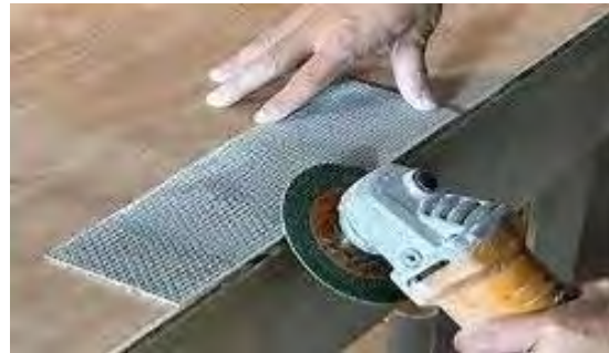
①角の部分の製品縁を45° に整える。
