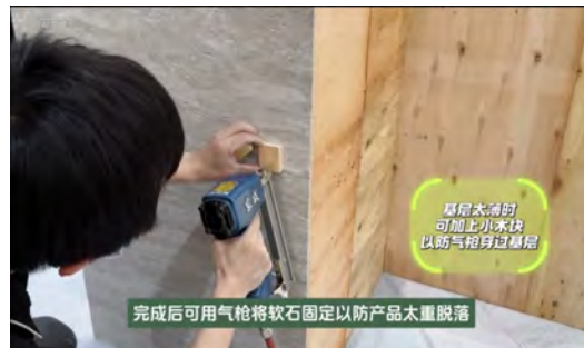
15.エアガンを使ってソフトストーンを固定し、製品が重すぎて落下するのを防ぐ
