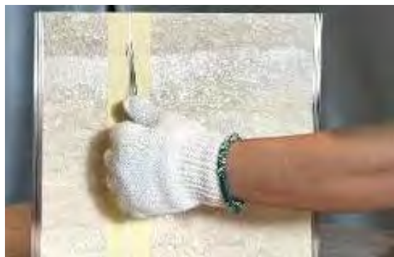
④製品が平らでない場合は、刃物で調整する。
