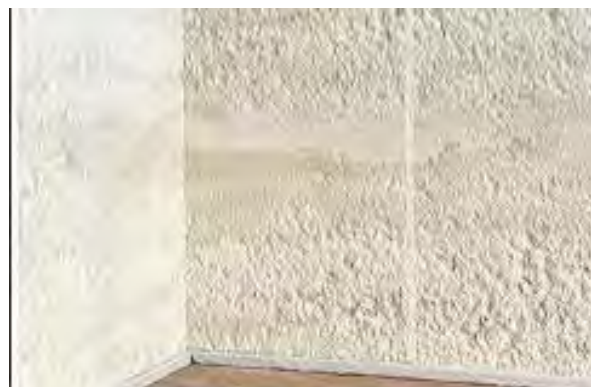
⑥漏浆縫の処理が完成。
