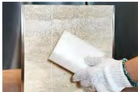
⑥乾いたスポンジで表面を清掃し、完成。
