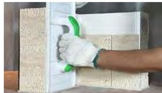
③貼り付けが完了したら、打ち板で製品をしっかりと押さえつける。手で押すのは厳禁。
