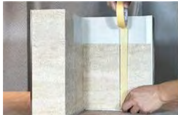
①製品に縫い目を残して貼り付けた後、製品の両側に美紋紙を貼る（凹凸のある製品は保護に注意）。
