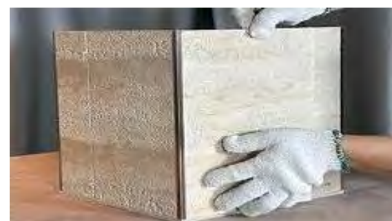
⑦製品を収辺条の縁に沿って貼り付ける。
