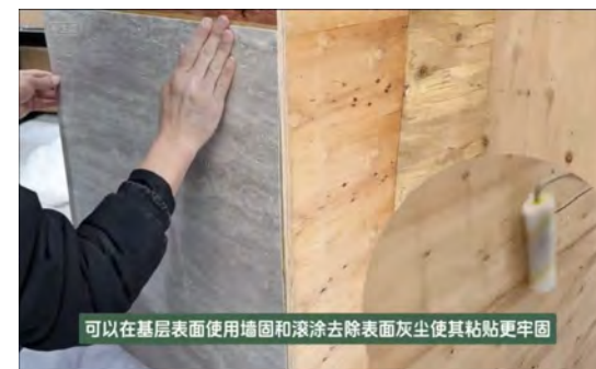
13. 下地表面に壁用プライマーを使い、 ローラーで塗って表面の埃を取り除くこと で、より強固に貼り付け可能
