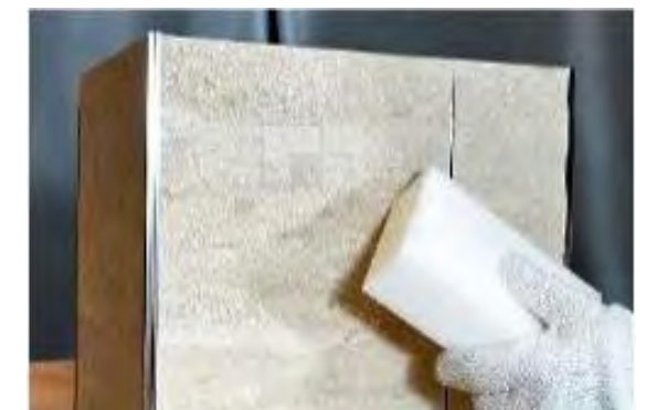
⑥乾いたスポンジで表面を清掃し、完成。
