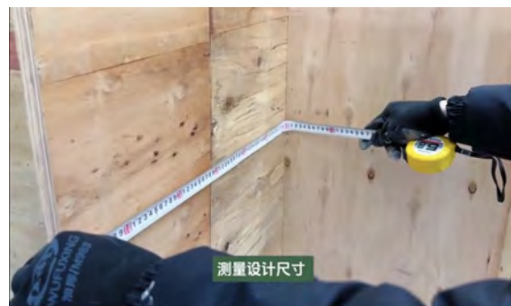
3. 設計寸法の測定
