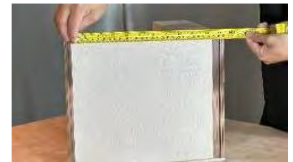
④収辺条を設置した後、製品が実際に壁に取り付けられるサイズを測定する。
